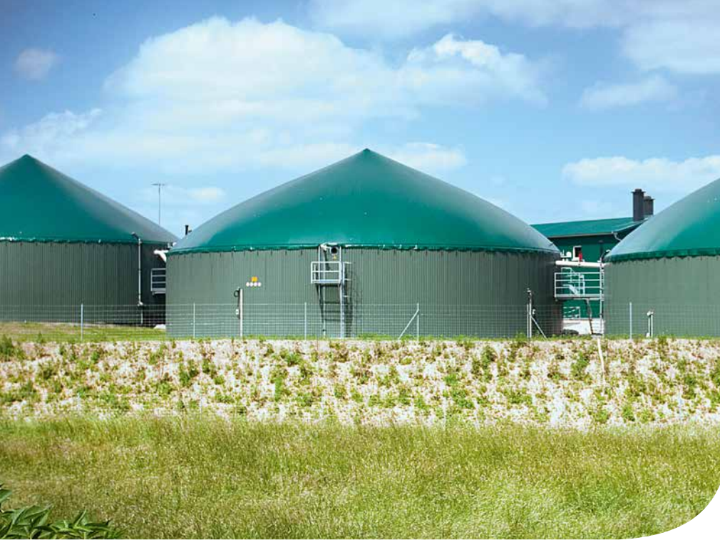
Anlagen der Stadtwerke Bielefeld zur Strom- und Fernwärmeversorgung.
