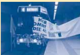
Eröffnung der Linie 4: erste Tunnelfahrt
