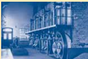
oben: Kesselhaus des Gleichstromwerks, 1900
