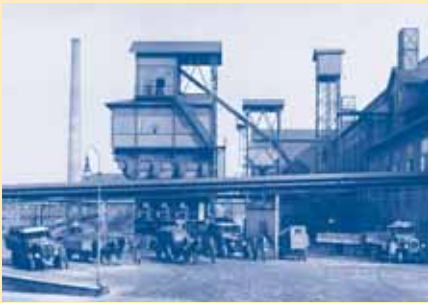
Das städtische Gaswerk, 1932
