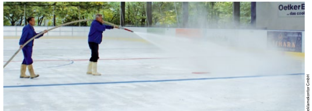
Zwei bis drei Nächte dauert es, bis die Eismacher rund 80 Kubikmeter Wasser scheibchenweise in eine vier Zentimeter dicke Eisschicht verwandelt haben.
