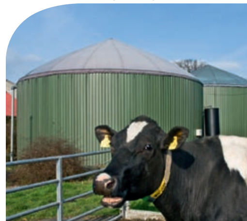
Biogasanlage Gut Wilhelmsdorf
