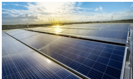
ZUSAMMENARBEIT BEI DER E-MOBILITÄT Betriebsleiter Michael Wellner schließt einen Dienstwagen an die Ladesäule an. Der Strom kommt von der PV-Anlage auf dem Dach des Außenlagers.
